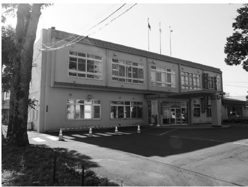
役場本庁舎外観(白老町公共施設等総合管理計画)
